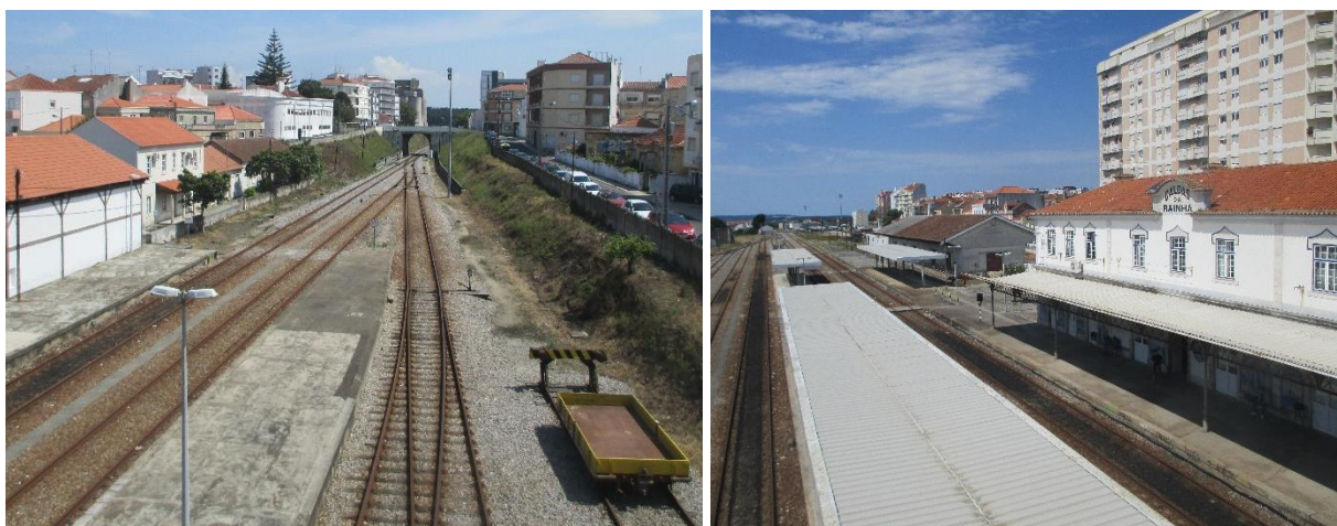
Figura 34. Linha do Oeste no perímetro urbano das Caldas da Rainha e Estação Ferroviária das Caldas da Rainha
