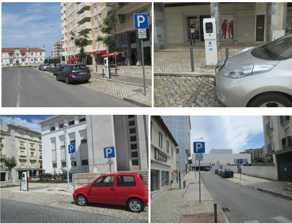
Figura 47. Postos de carregamento elétrico existentes na cidade das Caldas da Rainha
