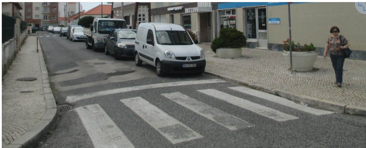
Figura 16. Barreiras arquitetónicas e urbanísticas à acessibilidade universal na cidade das Caldas da Rainha
